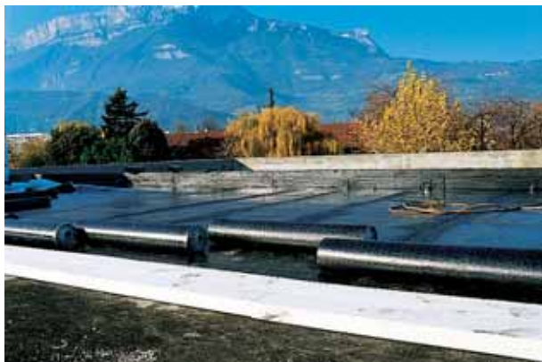
L'isolation d'une toiture-terrasse
