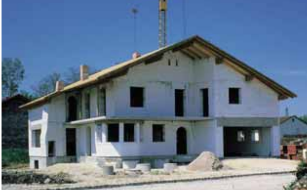
Construction en béton cellulaire
