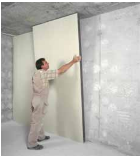
Pose d'un doublage isolant ; les isolants sont en laine minérale, PSE, PSX, PUR.
