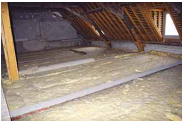
Pose de laine minérale sur le plancher d'un comble
